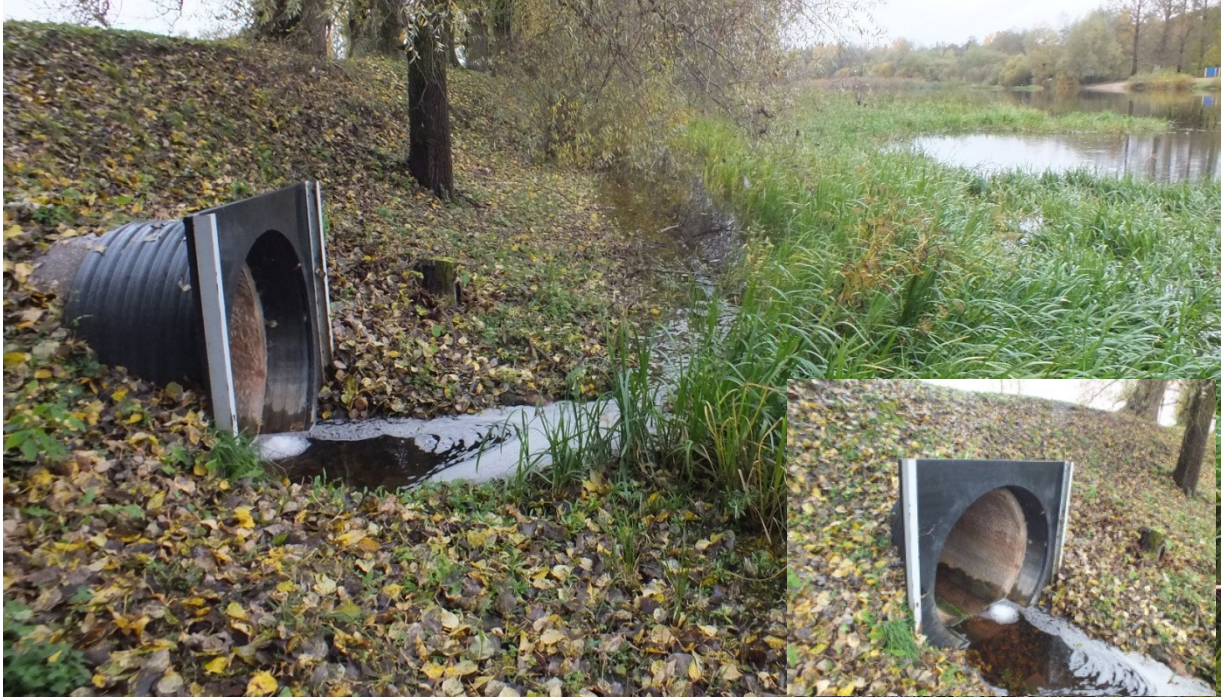
Foto 7. Varjaga suletava otsakuga truup Tartus Kauna tänava pikendusel. Emajõe kõrge veetaseme korral paigaldatakse vari ja kraavist pealevoolav vesi pumbatakse teiseldatava pumbaga kaitsetammi tagant Emajõkke.
