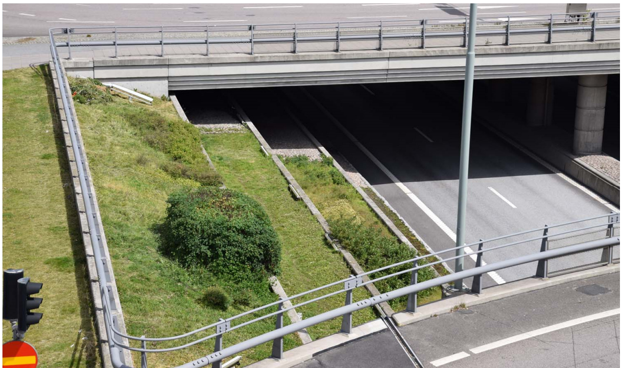
Foto 28. ITS võimalik kasutus viadukti aluse tee sulgemisel.
