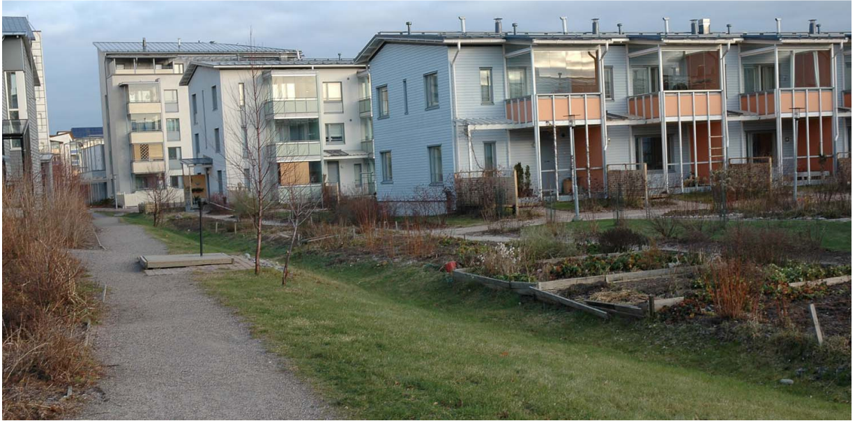
Foto 23. Hoonetevaheline roheline koridor. Näha on ka liigvee kogujana töötav nõva, lisaks peenrapinnad, mille veemahutavus on murust oluliselt suurem.
