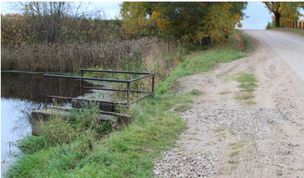
Foto 6. Plotina pais 18207 Niitsiku–Kahkva teel, Põlva maakonnas Mikitamäe vallas Kahkva külas 10.10.2017. Veetase on langenud tavapärasele tasemele, augud on täidetud killustikuga.
