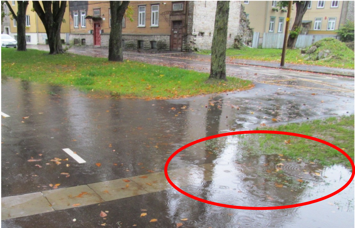
Foto 18. Hoone katuselt tänavale juhitud sademevesi on renniga suunatud sidekaabli kaevu. Vabriku tänav Tallinnas.
