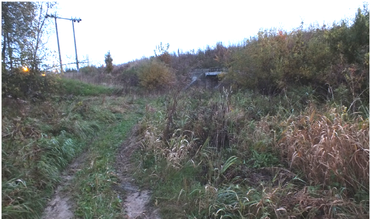
Foto 4. Raudteesild Kohtla-Nõmmel, Ida-Viru Maakonnas. Kohtla jõe säng on kuiv, silla alust ja jõesängi on kasutatud kohalikuks liikluseks. Praegusel ajal on sissepääs osaliselt ummistunud. Veevoolu taastumisel kunagisel kujul hajuks vesi kaldaga piirnevatele aladele.
