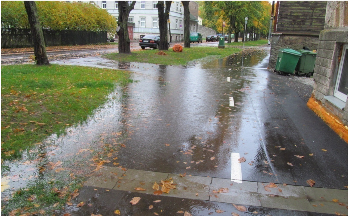
Foto 20. Kergliiklusteelt haljasalale juhitud vesi on voolanud reljeefi madalamasse punkti, jõudmata imbuda. Vabriku tänav Tallinnas.
