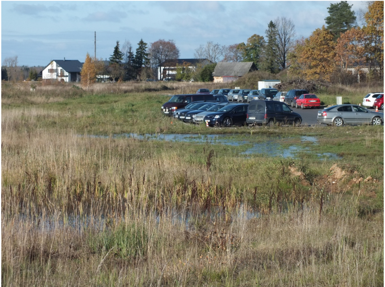
Foto 13. Parkla endisel põllumajandusdrenaažiga kuivendatud alal. Põllul olev veepind on parkla asfaltkattega samal kõrgusel, Tartu maakond.
