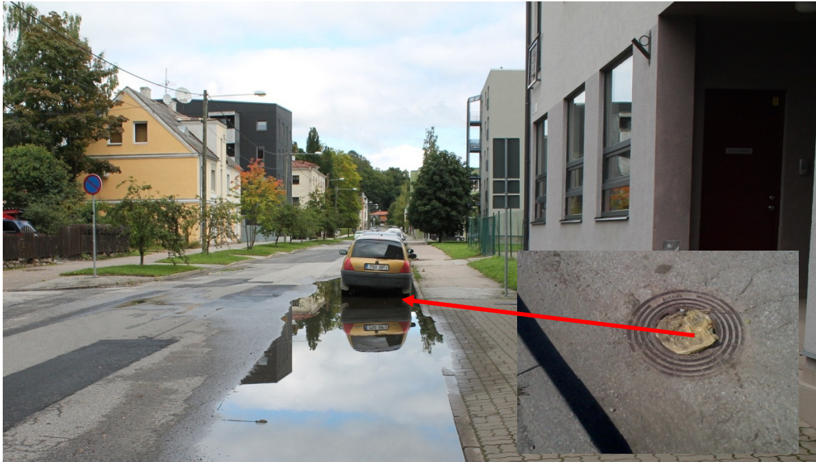
Foto 25. Ummistunud restkaev Tartus Kivi tänaval.
