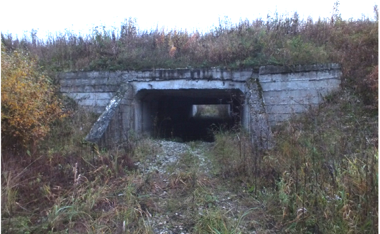
Foto 3. Raudteesild Kohtla-Nõmmel, Ida-Viru Maakonnas. Kohtla jõe säng on kuiv, silla alust ja jõesängi on kasutatud kohalikuks liikluseks. Praegusel ajal on sissepääs osaliselt ummistunud. Veevoolu taastumisel kunagisel kujul hajuks vesi kaldaga piirnevatele aladele.
