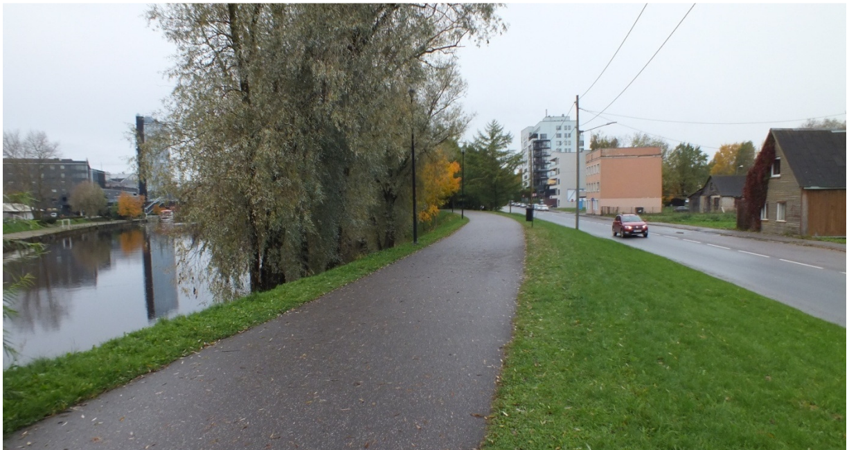
Foto 8. Tamm Fortuuna tänava ja Emajõe vahel. Emajõe kõrge veetaseme korral suletakse jõkke suubuv torustik ja sademevesi juhitakse tänavalt reoveekanaliseerimisele.
